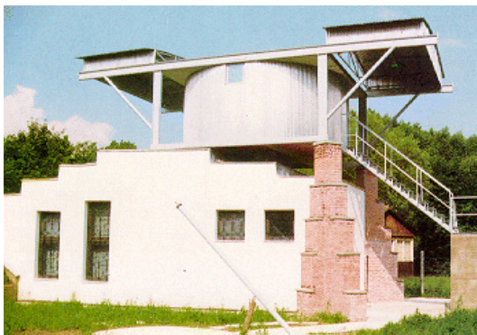
9. ábra. Az épület.
