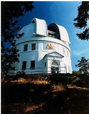
25. ábra: A victoriái (Kanada) Dominion Obszervatórium (1918)
